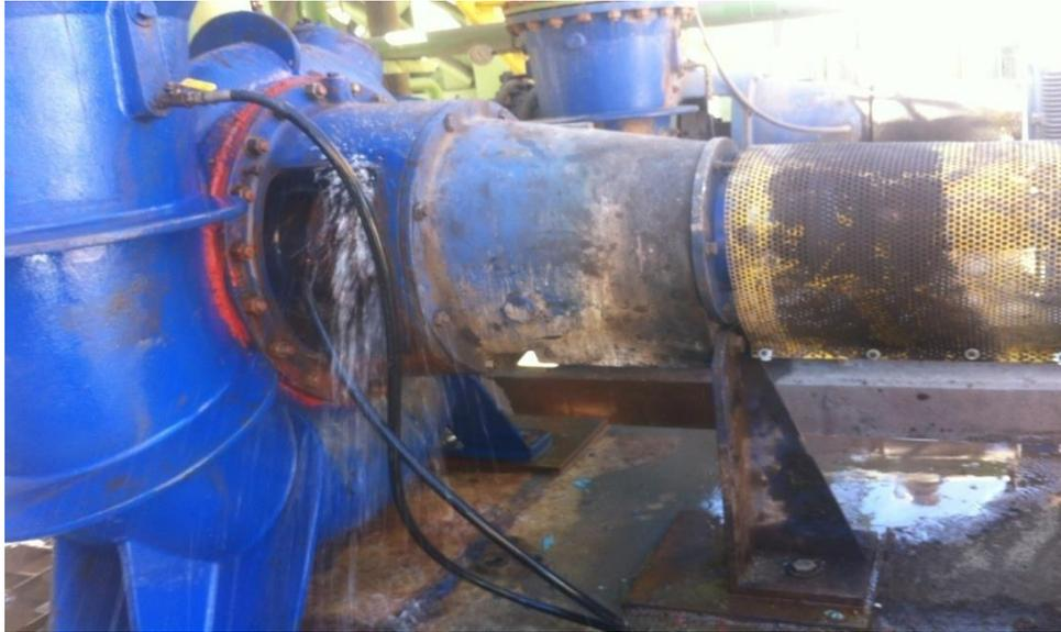
El agua de la prensa estopa actúa continuamente en forma directa sobre la tapa de la caja porta rodamientos, ingresando al interior de generando oxidación, pérdida de lubricación y corrosión en el interior. Transformándose en una falla en cadena catastrófica y en aumento, acortando la vida útil de los componentes del equipo. Además de incrementar el costo hídrico del agua en la planta.
