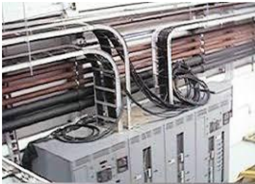
Figura n°23: Bandeja metálica distribución de cables de control.
