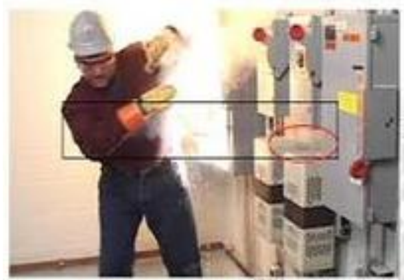
Figura nº2: Exposición de arco flash o arco eléctrico.
