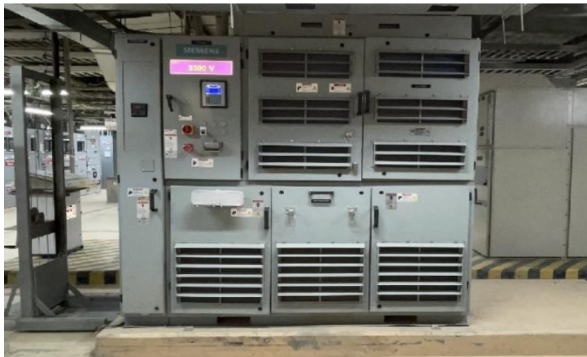
Figura N°9. VDF Robicon de 805[HP] / 3300 [V]
