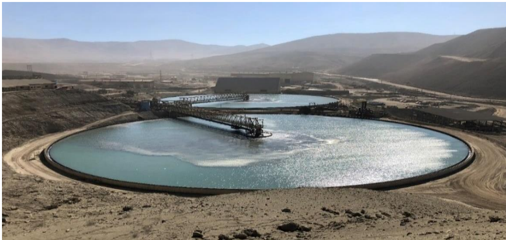
Figura N°5. Vista de espesadores de relaves, Fase 1 y Fase 2.
