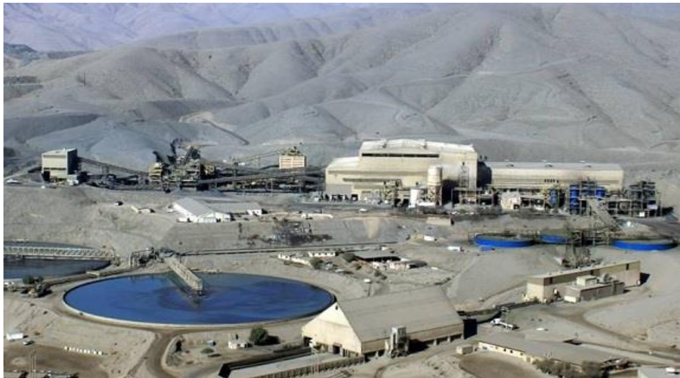
Figura N°4. Vista de Planta Concentradora Minera Candelaria.
