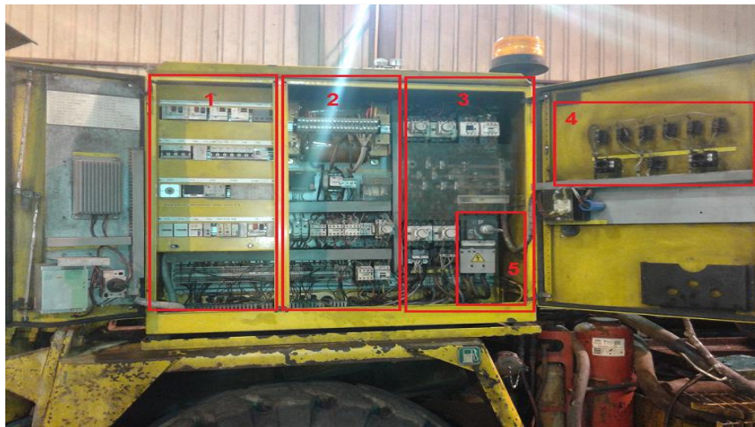
Figura 5.10.3 Tablero del panel A
