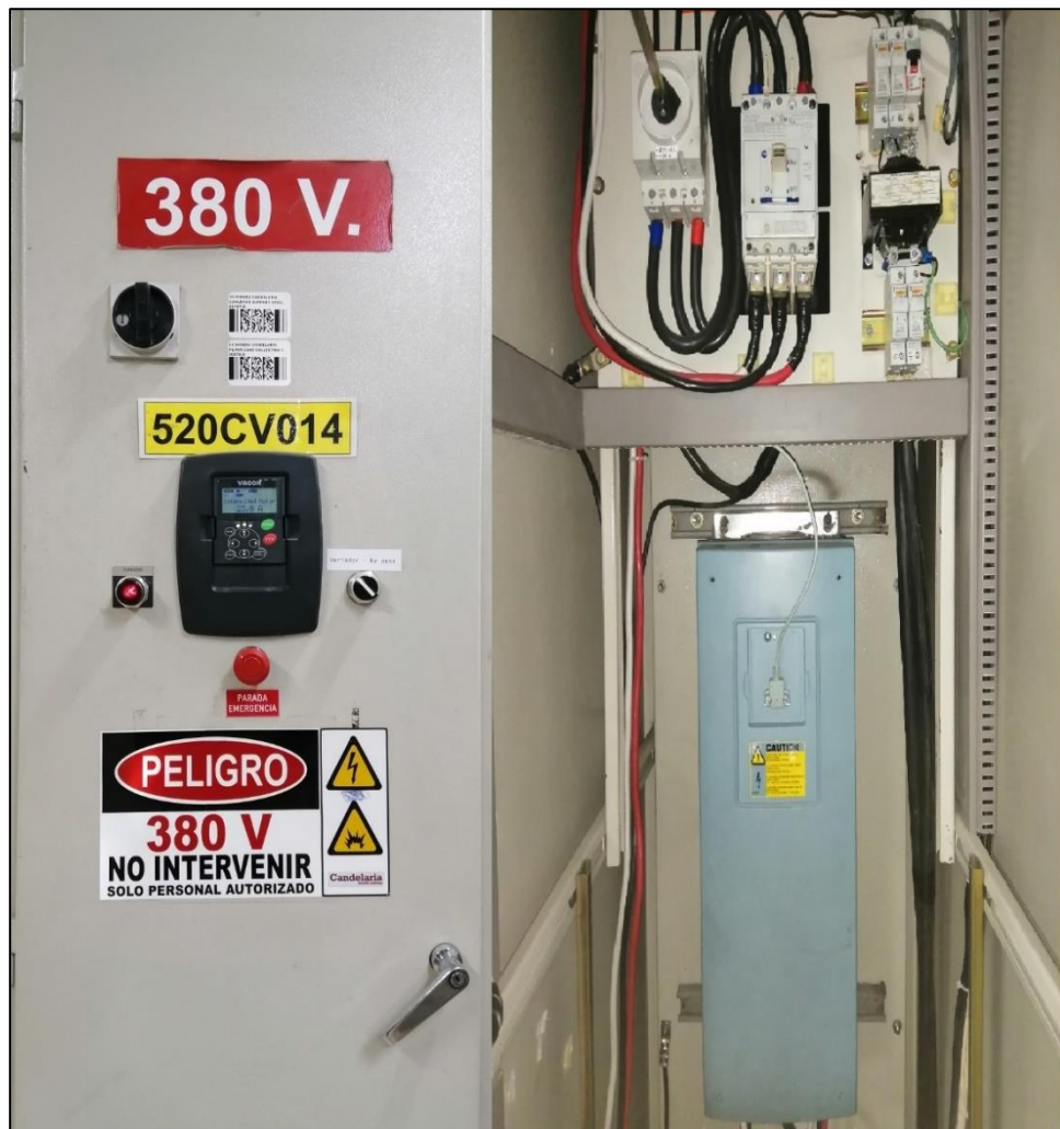
Figura 3.5. Montaje del VDF.
