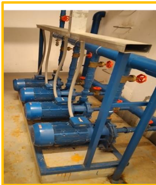
Fig. N°16, Bombas centrífugas.
