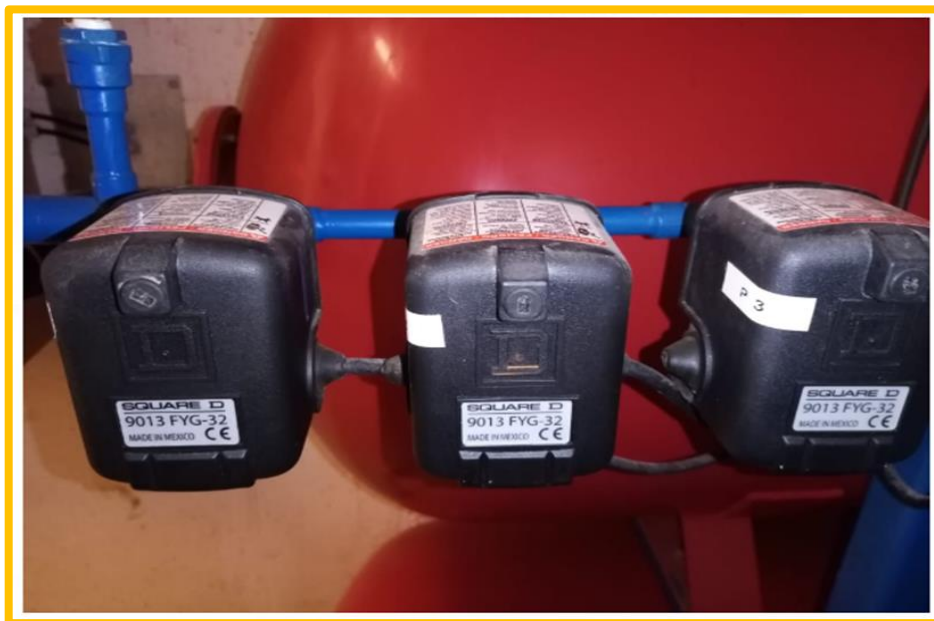
Fig. N°20, Presostatos.
