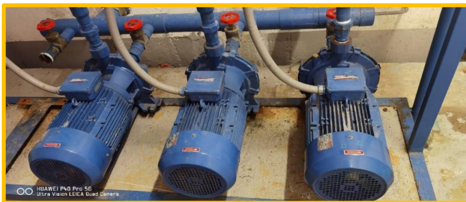
Fig. N°17, Bombas centrífugas.
