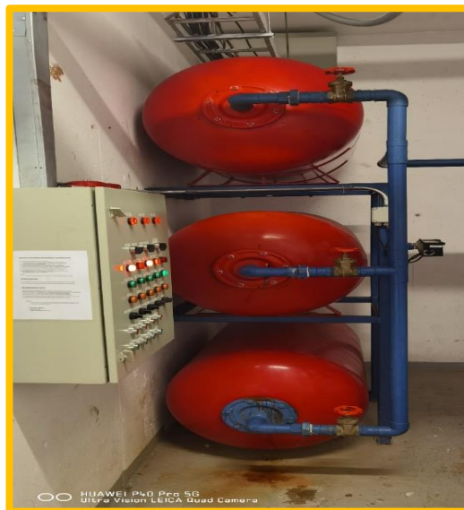
Fig. N°18, Estanques hidroneumáticos.
