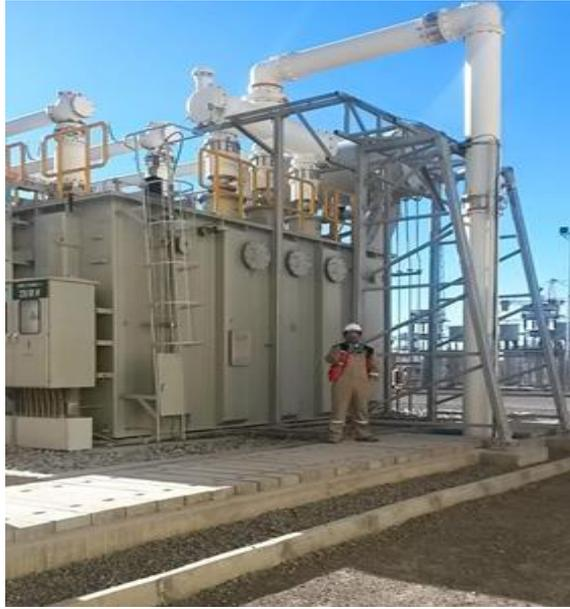
**Figura N° 5.2: Pruebas eléctricas a transformador de poder 220KV/69KV 150 MVA Proyecto EWS Subestación Domeyko Minera Escondida BHP Billiton.**
