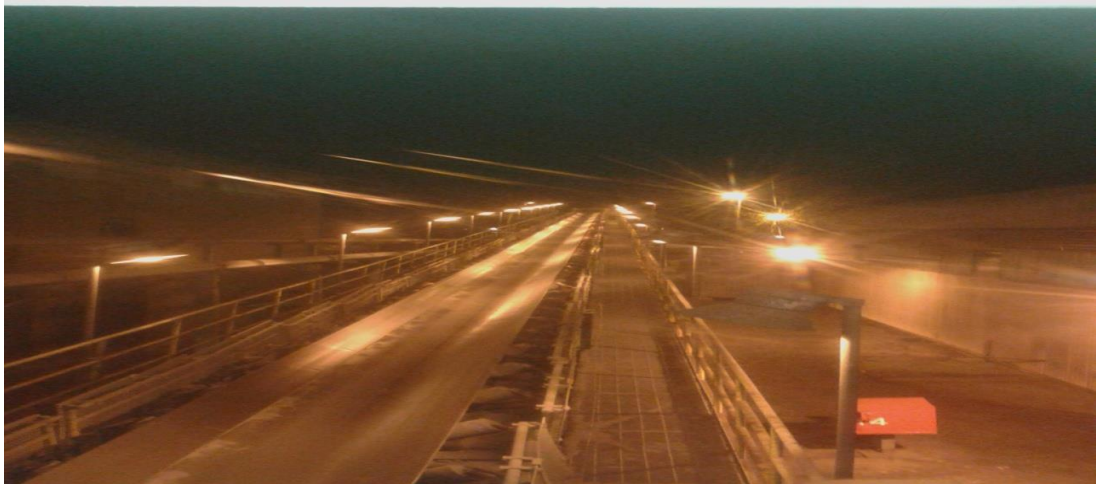
Figura N° 4.14: Vista frontal de iluminación antigua de las Correas Transportadoras.
