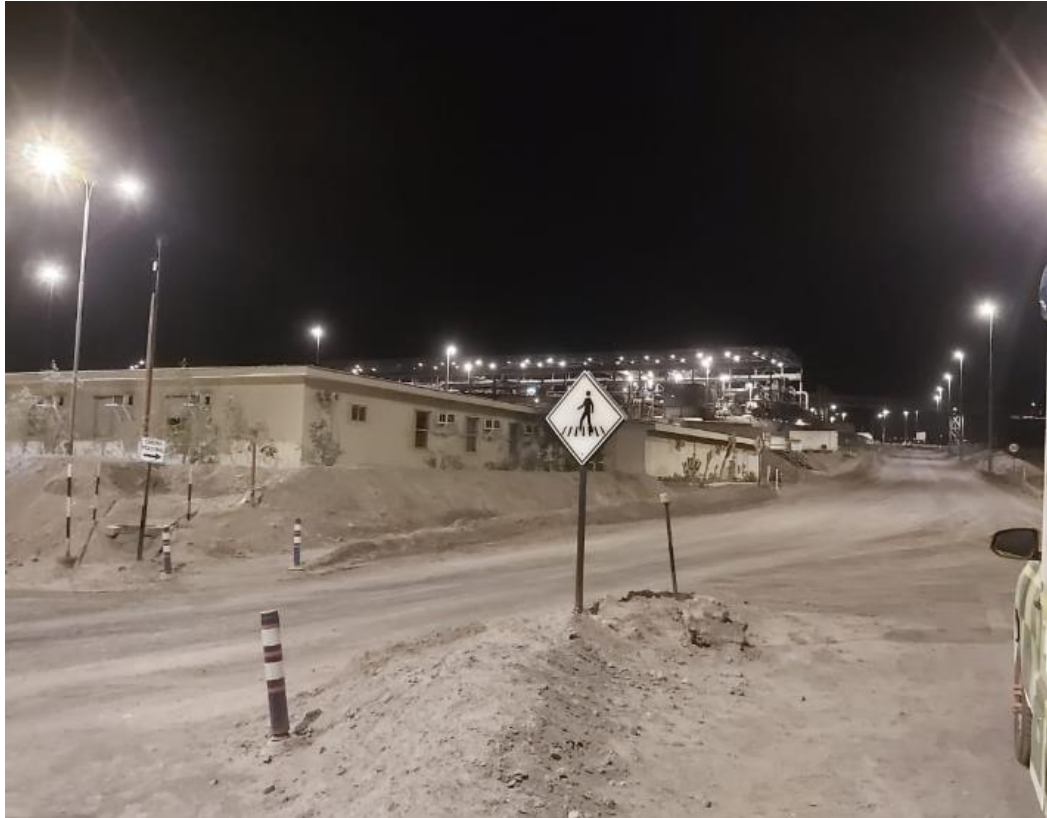
Figura N° 4.42: Vista desde garita de la iluminación de Planta Magnetita.
