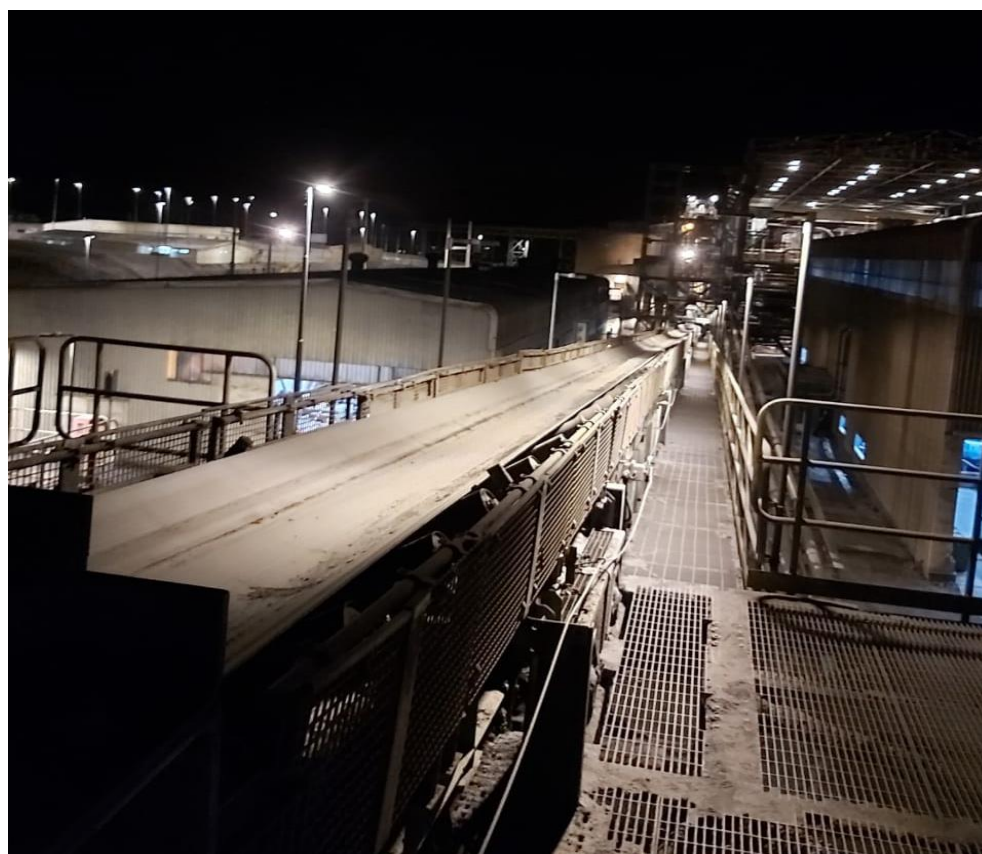
Figura N° 4.15: Vista frontal de iluminación nueva de las Correas Transportadoras.
