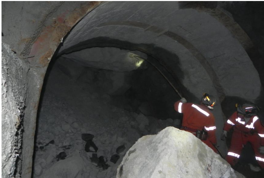
Figura N° 3.6. Operación para descolgar Zanja a una parada (Fuente Propia)
