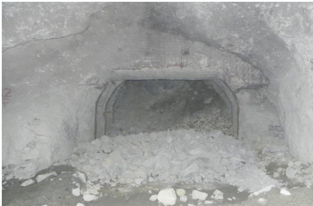
Figura N° 3.7. Operación para descolgar Zanja mayor a una parada (Fuente Propia).
