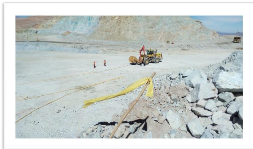
Figura N° 4.3: Instalación de cable en circuito
