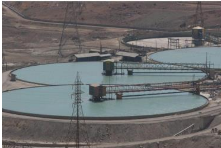
Figura 2.15: Planta concentradora la teniente. Fuente, Codelco
