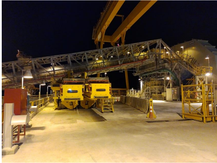
Figura N° B.1: Vista general correa.
