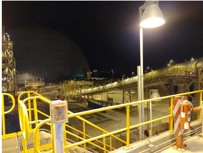
Figura N° B.3: Vista general acceso a correa.
