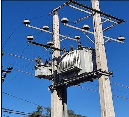
En la figura 4.2. se observa que el transformador se encuentra instalando en altura soportado por vigas de acero entre dos estructuras de media tensión, además cuenta con un equipo compacto de medida para la lectura de datos. Debajo en las mismas estructuras se encuentra ubicado el tablero general correspondiente con su respectiva protección de baja tensión en la cual llegan dos alimentadores por fase como se observa en la figura 4.3.
