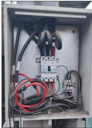
Las sondas de voltaje del equipo de medición se instalaron en cada fase y también hacia el neutro del sistema eléctrico, estas en un tablero aguas abajo del tablero general, en una barra común como se observa en figura 4.9.
