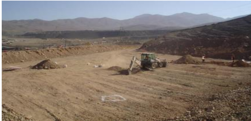
Figura N° 5.3: Limpieza de área y nivelación de terreno.
