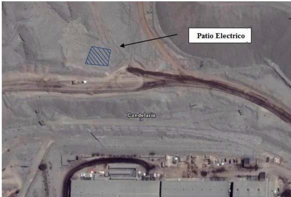
Figura N° 5.7: Emplazamiento destinado para el patio de generación eléctrica Minera Candelaria.
