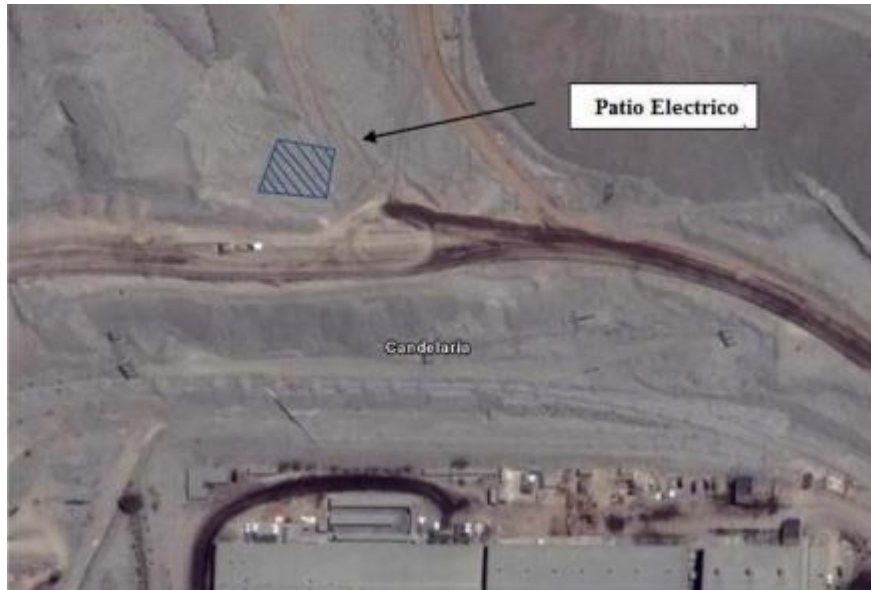
Figura N° 5.1: Patio de generación. Lugar (Fotografía) emplazamiento patio de generación.
