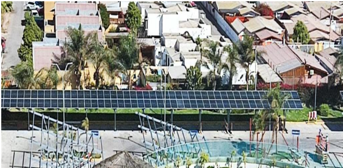
Ilustración 9 Montaje de Paneles
