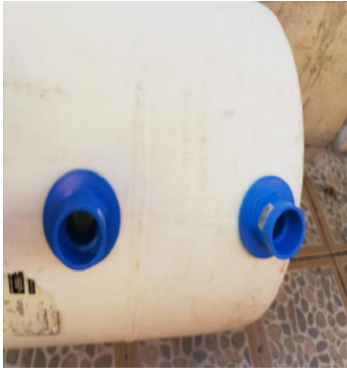
**Figura N° 4.5: uniones de estanque 50 mm Instaladas.**
