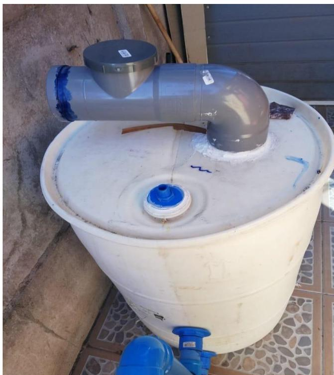
**Figura N° 4.8: Ensamble de tuberías y sellado con silicona antihongos uniones y aperturas.**
