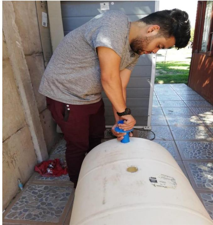
**Figura N° 4.4: Colocación de unión de estanque 50mm.**
