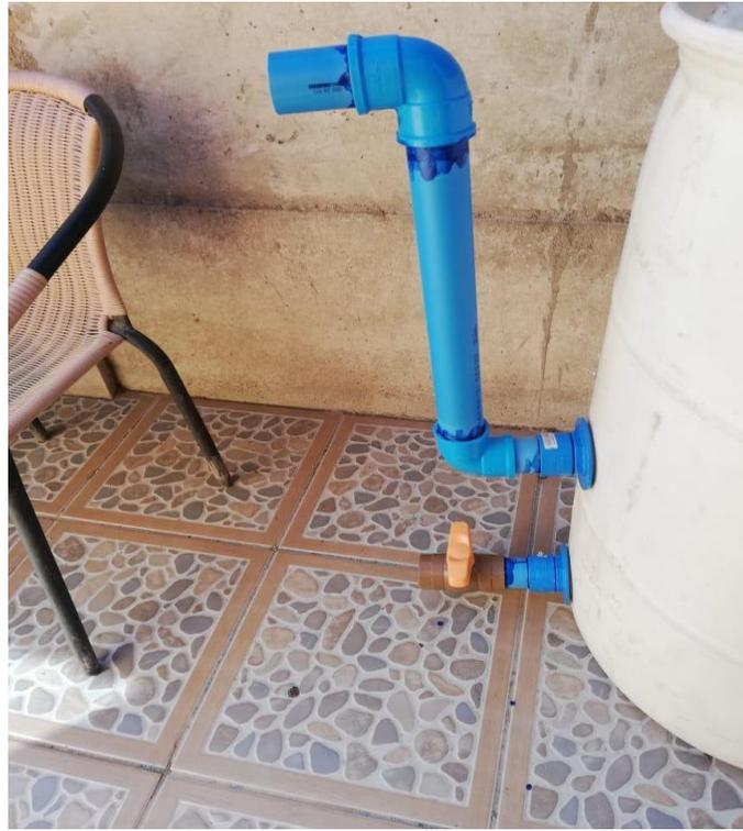
**Figura N° 4.9: Ensamble de codos, tuberías y válvula esfera para la salida de efluentes.**
