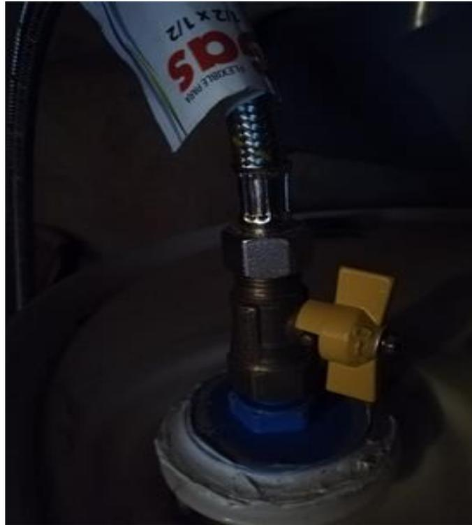
**Figura N° 4.10: Instalación de llave y manguera de gas.**
