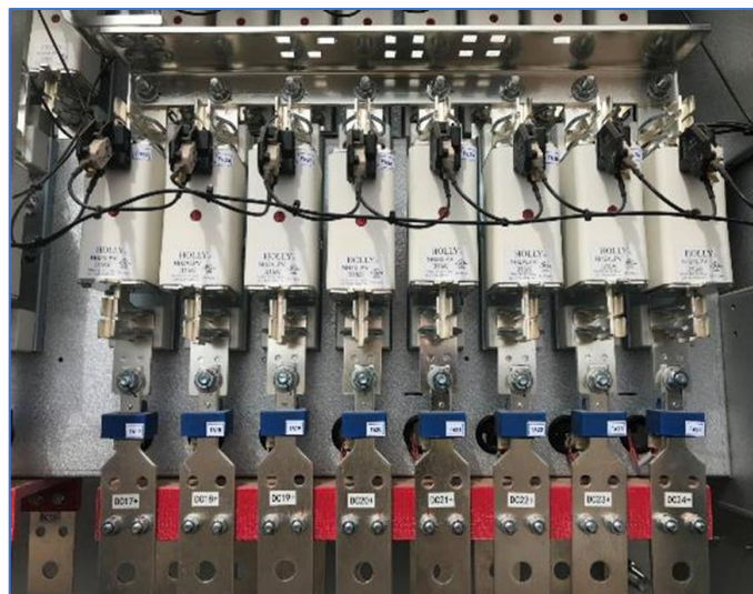
Figura 5.12: Fusibles DC.
