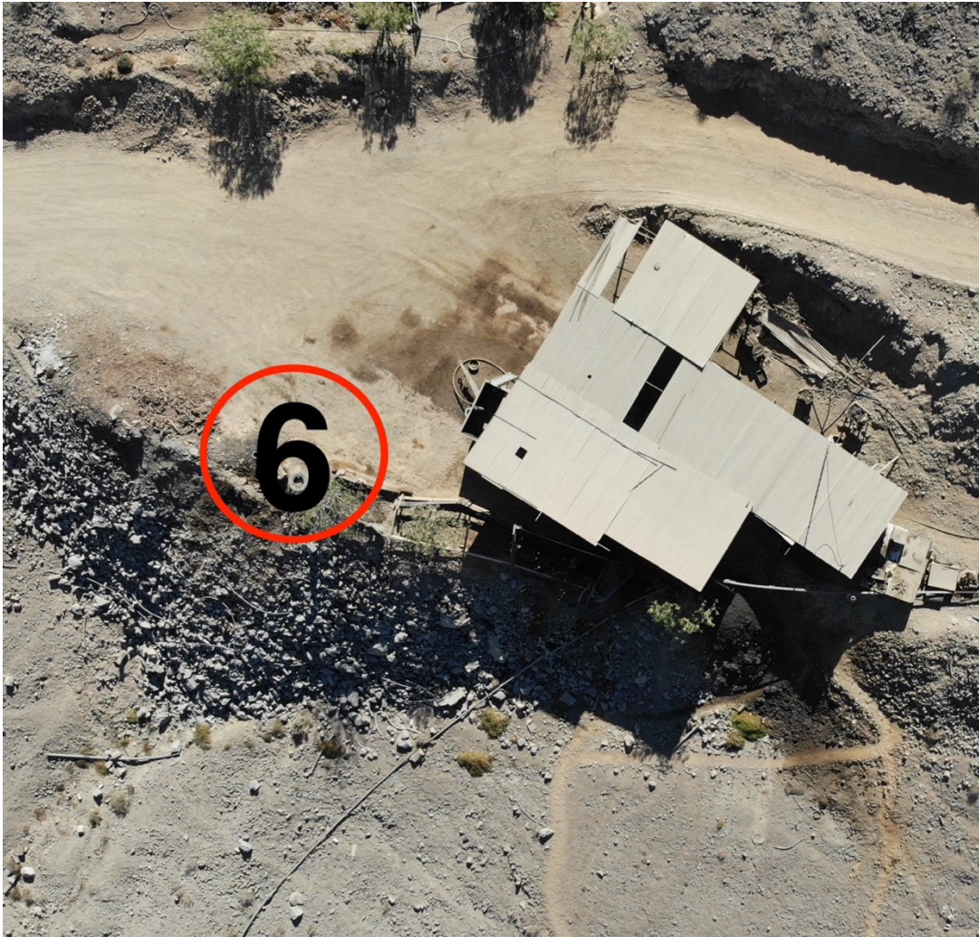
Imagen 9: Área de compresores SOPLENA
