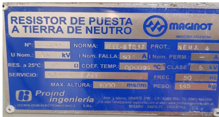
Figura N° 3.18: Placa de datos resistencia al neutro.
