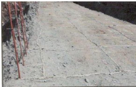
Figura N° 3.15: Registro fotográfico tendido de malla 11m x 11m.
