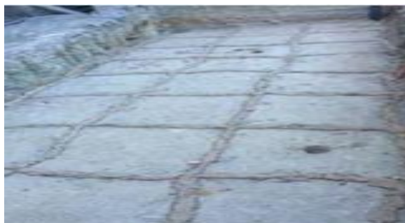
Figura N° 3.17: Registro fotográfico mejoramiento del suelo.
