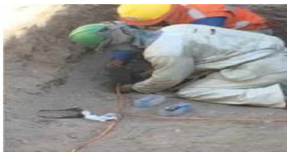
Figura N°3.16: Registro fotográfico realizando soldadura exotérmica.
