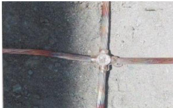
Figura N° 3.14: soldadura exotérmica.
