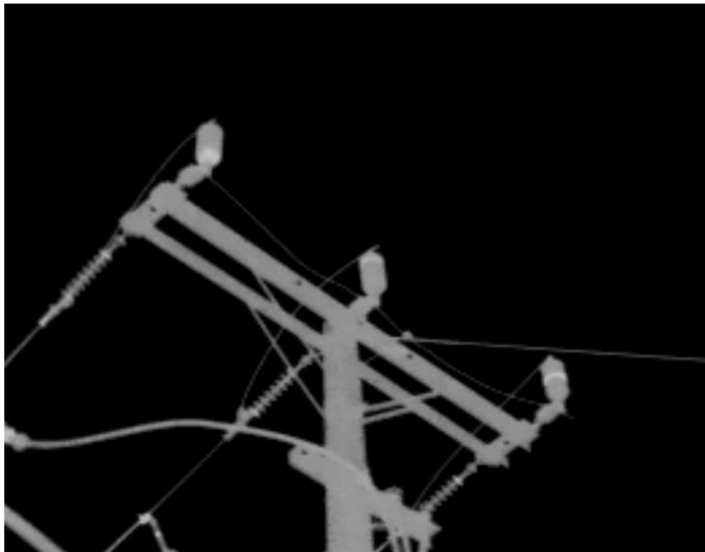
Figura N° 2. 14 Imagen térmica pararrayo
