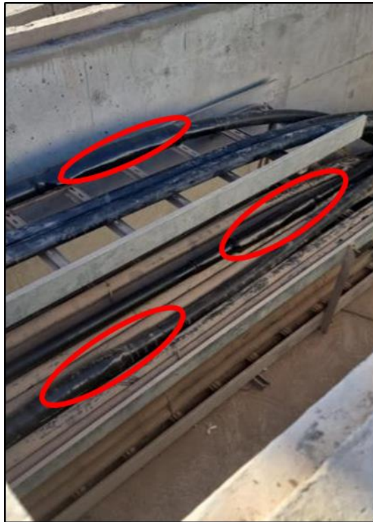
Figura 5.7 Empalmes de MT para unión de cables nuevos.
