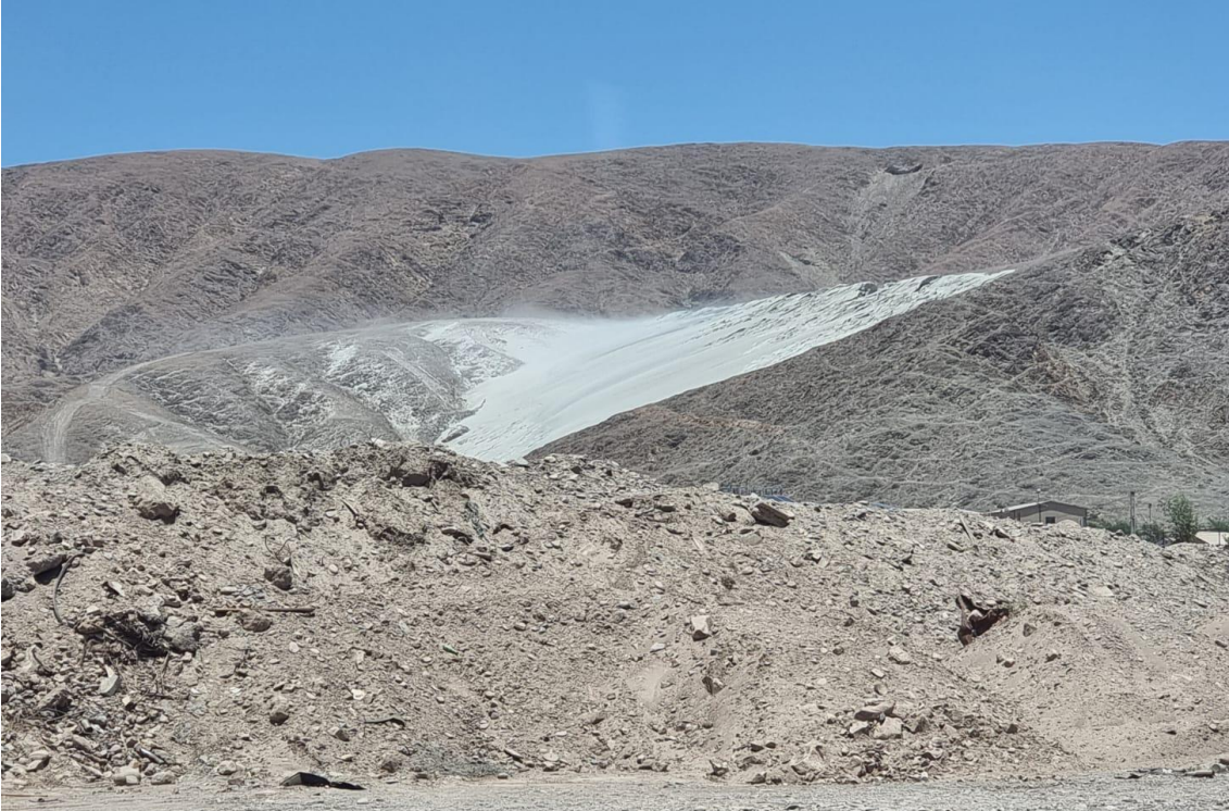
Foto 17, Pto.16, La foto muestra erosión eólica de relave.
