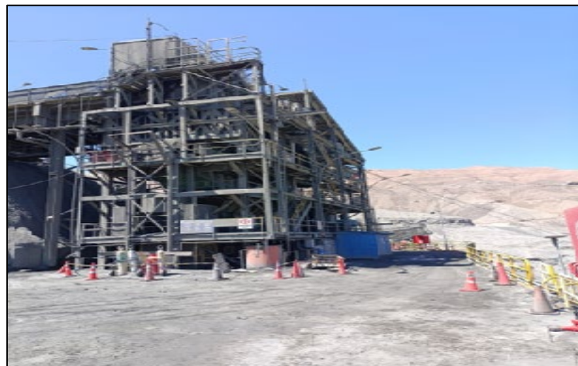
Figura N° 1.3: Vista general edificio chancado primario.
