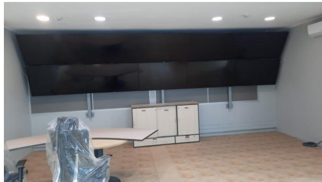
Figura N°4.5: Finalizando el proyecto de montaje.
