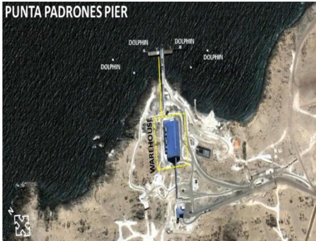
Figura 1.1: vista área de puerto punta padrones Pier
