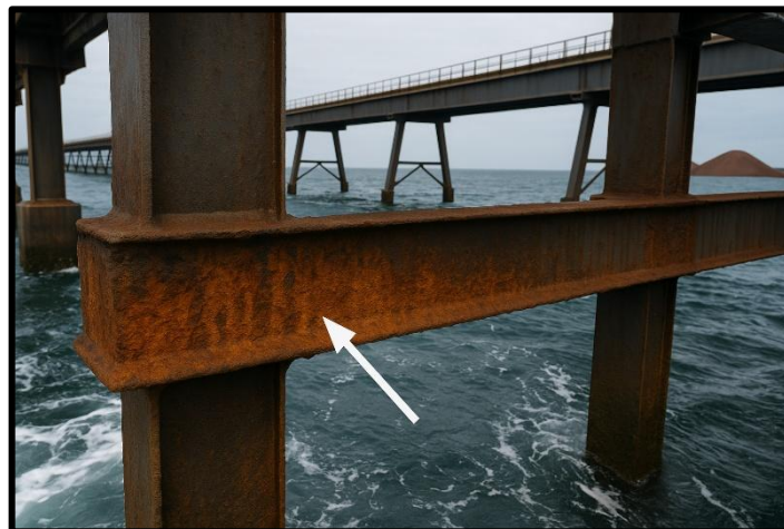
Figura 2.4 Corrosión generalizada
