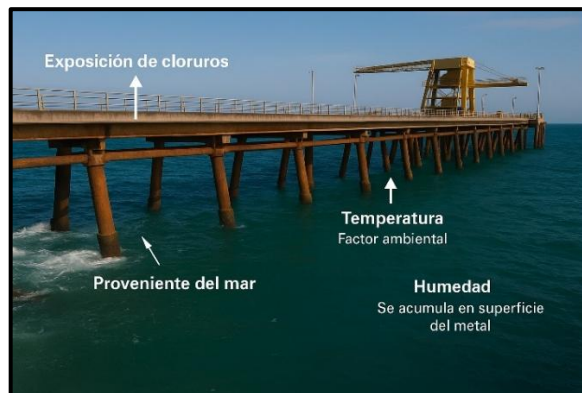
Figura 2.1 Imagen referencial de causas de corrosión
