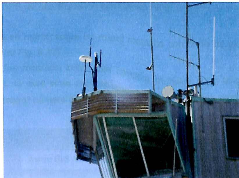
Fig. 6.16 Antena GPS de alta precisión con Choke Ring en Despacho
