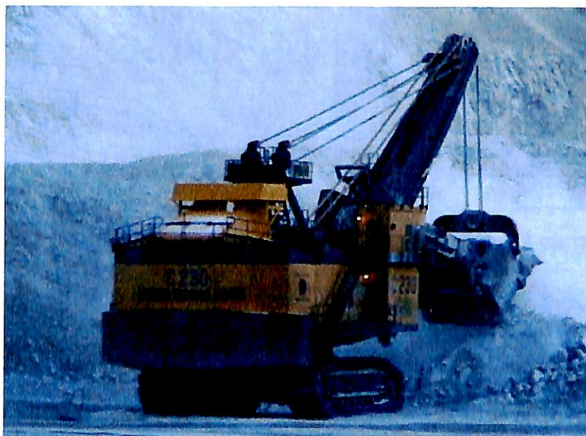
Fig. 4.4 Pala en proceso de excavación
