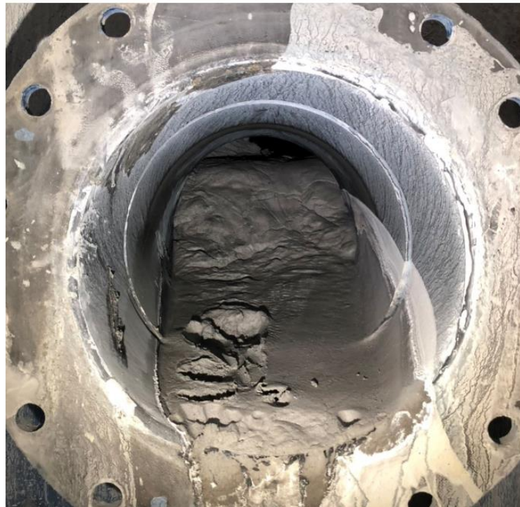
Figura N° 2.19: Ciclón en condiciones de embancamiento.
