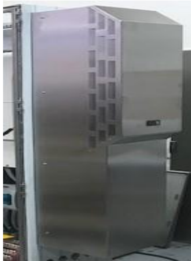
Figura N° 4.2 Gabinete de aire acondicionado
