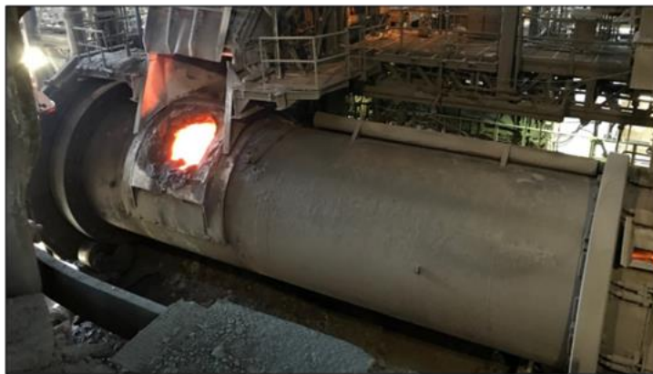
Figura N° 2.3 Convertidor Teniente Enami Paipote
