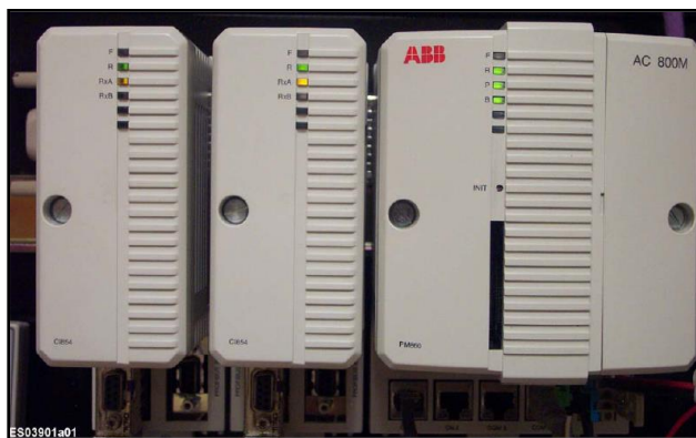
Figura N° 3.2: AC800MM con módulos de interfaz para profibus DP-V1.
