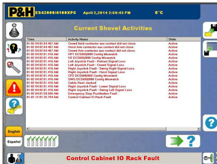
Figura N° 4.12: Indicación de falla y alarma del equipo.
