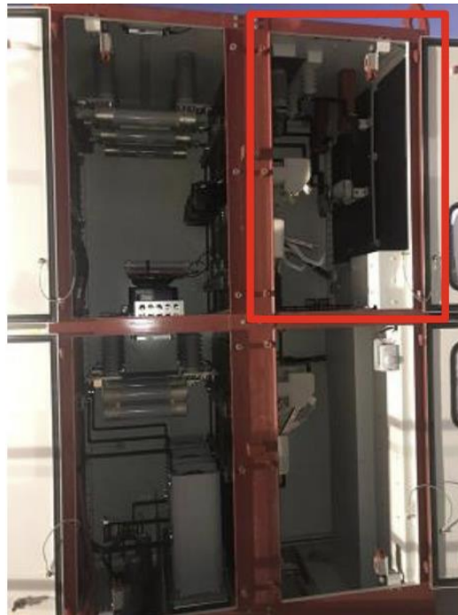
Figura 1.5. Puntos Medición en Desconectador H.V. Superior.
