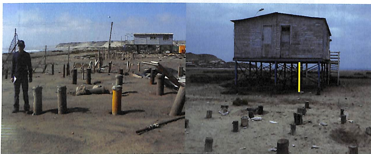
Figura 5.10. a) Línea de construcción más cercana a la costa, arrancada por el tsunami b) Vivienda con inundación observada de 1,9 m, correspondiendo a inundación máxima en altura.
