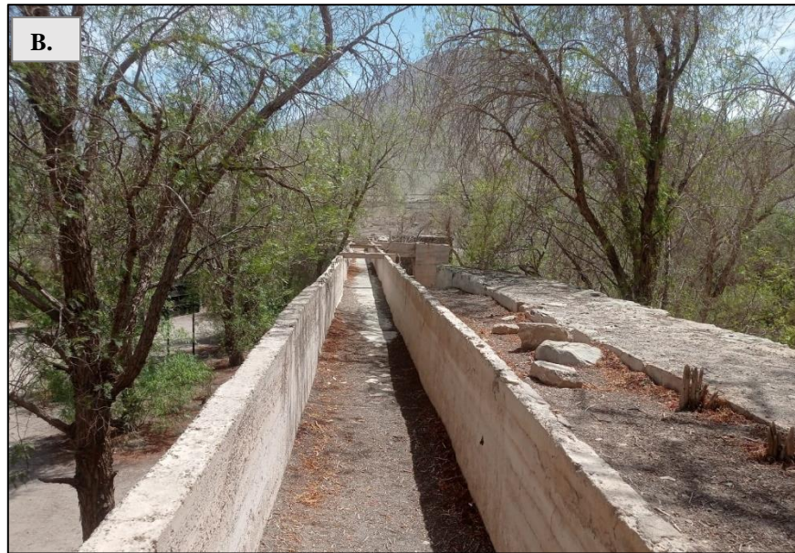
Figura 6. 17. Acueducto Amolanas. A. Estructura de cascada artificial por donde caía el agua. B. Puente superior por donde se realizaba el transporte de agua.
