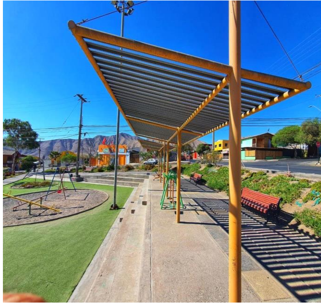
Imágen N° 3.1.4 Vista específica de estructuras. Este soporte permitirá la instalación de paneles fotovoltaicos.
