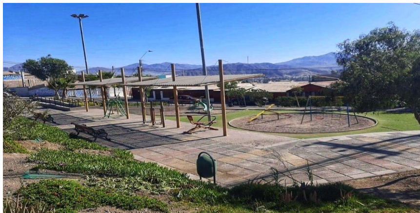
Imágen N° 3.1.3 – Vista General de plaza. Se puede observar estructuras que permitirán instalar sistema fotovoltaico.
