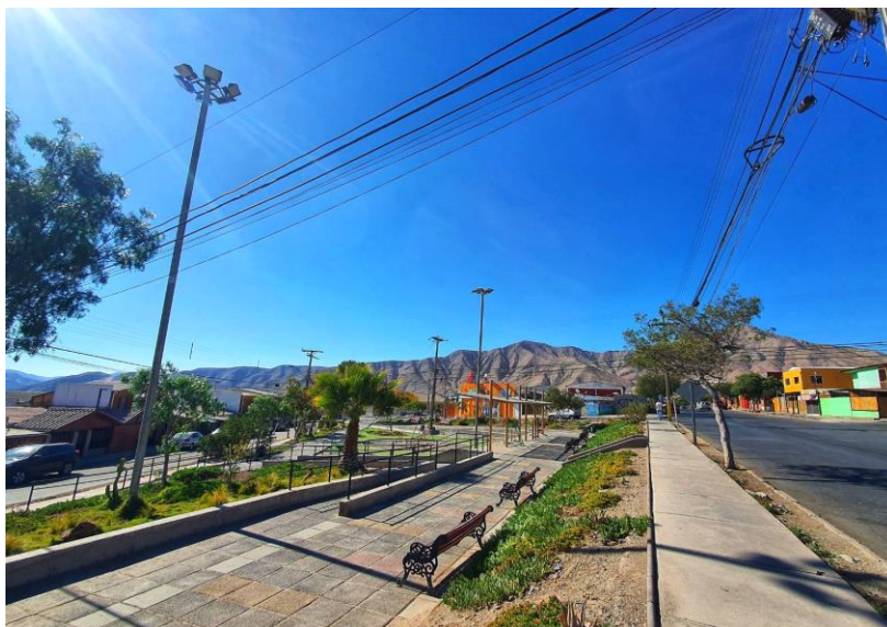
Imágen N° 3.1.2 – Vista General de plaza. Se puede observar poste con iluminación halógeno (400w).
