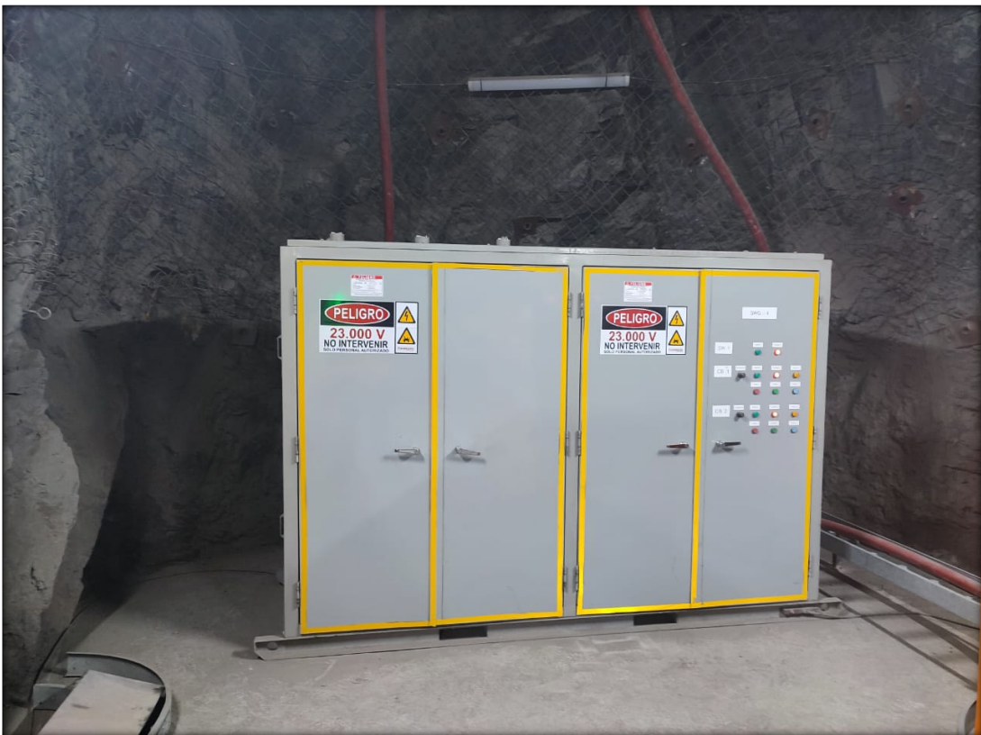
Figura N° 3.4: Switchgear nivel 430.
