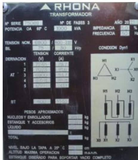
Figura N°3.2: Placa de Subestación nivel 100 Cristina-irma
