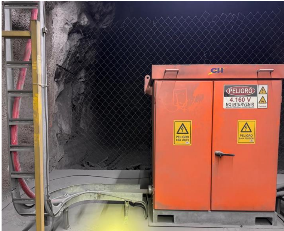
Figura N°4.7: Alimentación de subestación en media tensión
