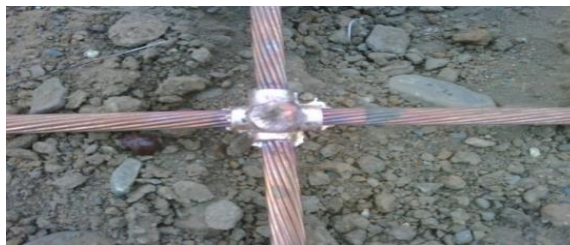
Figura N°3.4: Soldadura exotérmica de unión en SPAT.
