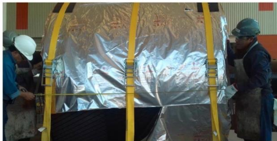
Imagen 3 Medición de largo del manto.
