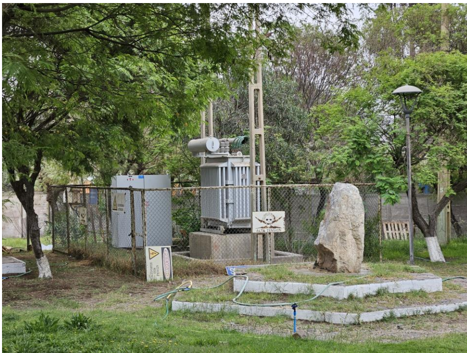
Figura N° 4.1: Subestación 400 [kVA].
