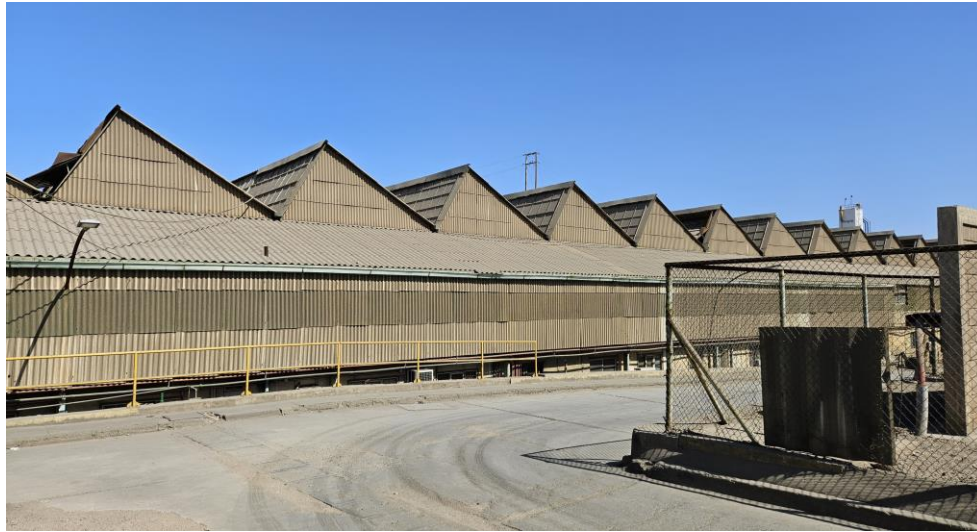
Figura N° 4.14: Vista lateral del taller de mantención.
