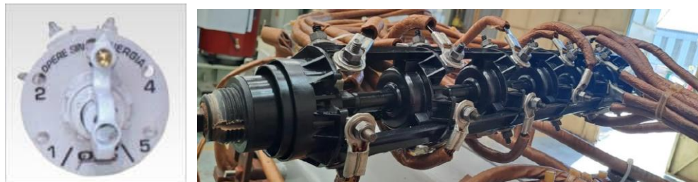
Figura 2.12. Cambiador de Taps de transformador de poder
