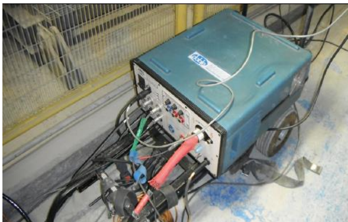
Figura N°3.14: Medidor de Factor de Potencia y Corriente de Excitación (Delta M-4000).
