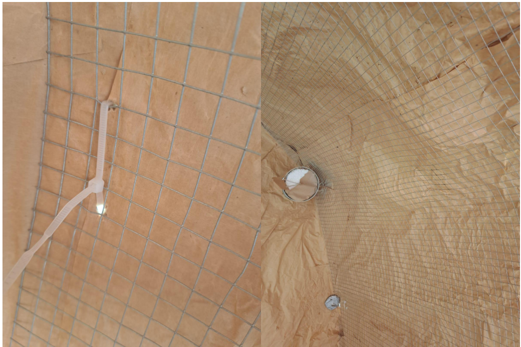
Ilustración 3. 12 Instalación de malla
