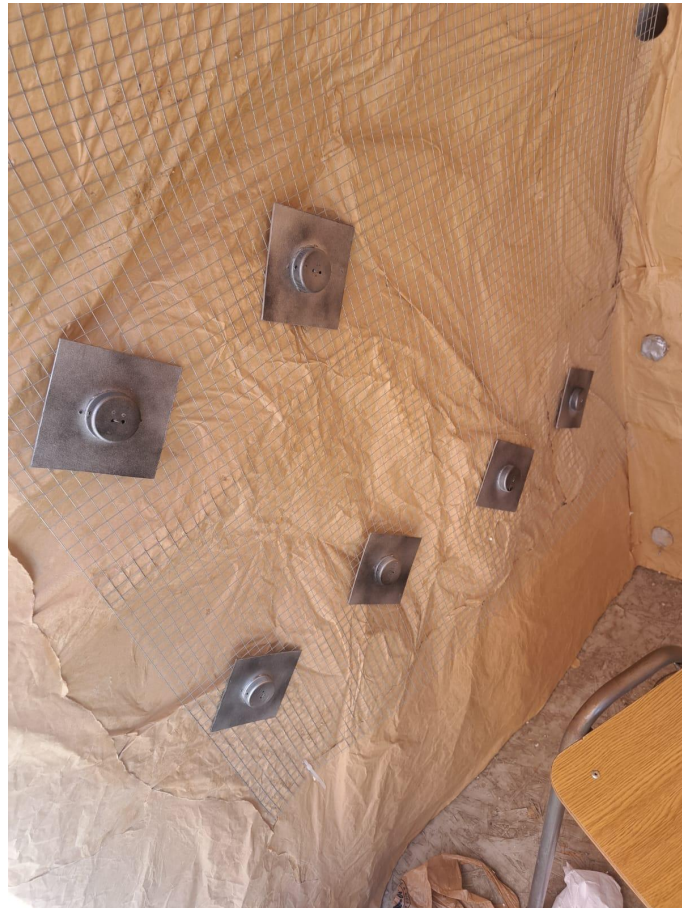
Ilustración 3.13 Representación de pernos de fortificación
