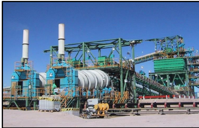
Figura N°6 Vista general del tambor aglomerador dentro de una empresa.
