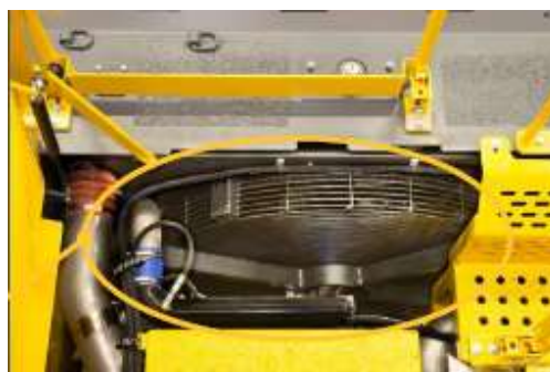
Figura N° 3.24: Enfriadores vista superior.
