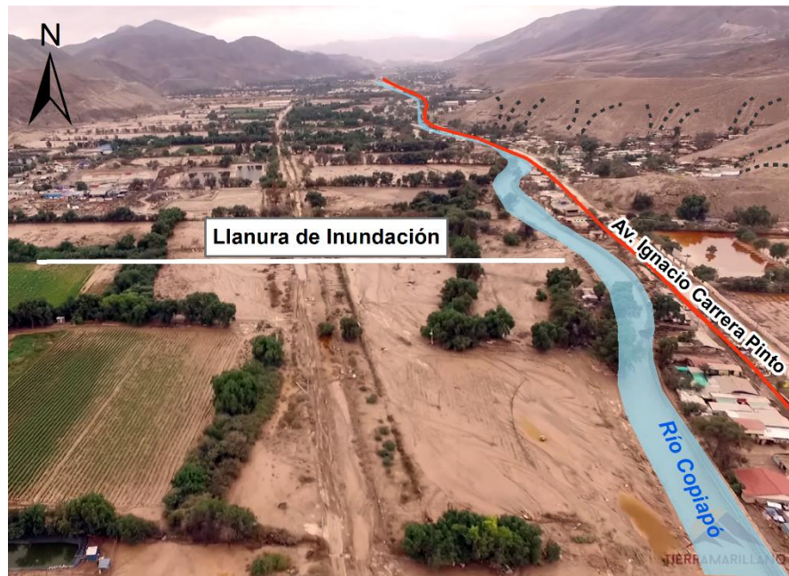
Figura 91: Vista aérea con vista al norte en cercanías del Punto 3 (sector sur). En línea blanca se indica la extensión de la llanura de inundación casi en su totalidad con presencia del flujo aluvional producto del desborde e inundación. Extraído y modificado de Eltierramarillano.cl (agosto, 2023).
