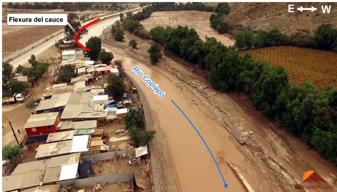
Figura 90: Imagen aérea por dron en el sector extremo sur del área de estudio. Este sector es el punto 1 de desborde (sector Algarrobo), en donde se indica con línea de color rojo la flexura del cauce, cuyo flujo desbordó en esa curva inundando a las viviendas aleñadas a la ribera. Extraído y modificado de Eltierramarillano.cl (agosto 2023).
