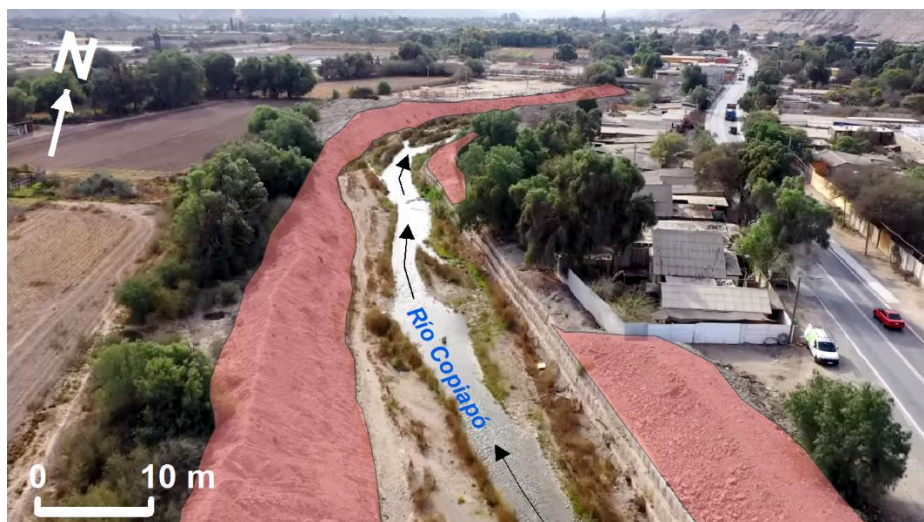
Figura 96: Imagen aérea del sector centro captada el año 2018, en donde se identifica, en color rojo el depósito acumulado de material como medida de mitigación (barreras longitudinales) en ambos flancos del cauce, ante desbordes del río. Extraído y modificado de Eltierramarillano.cl (agosto, 2023).
