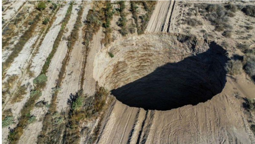
Figura 27: Socavón ubicado en la entrada norte de la Comuna de Tierra Amarilla. La cavidad cilíndrica tiene un diámetro de 36-38 m con una profundidad de 64 m, totalizando un volumen de 65.100 m 3 aproximadamente. Extraído de bbc.com .
