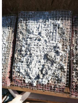
Ilustración 26: Talud 25% Relave Cobre.
