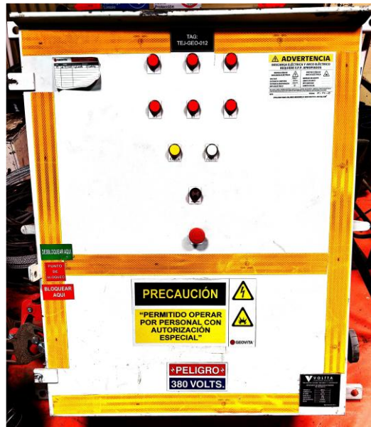
Figura 3.4 Exterior TEJ nuevo.
