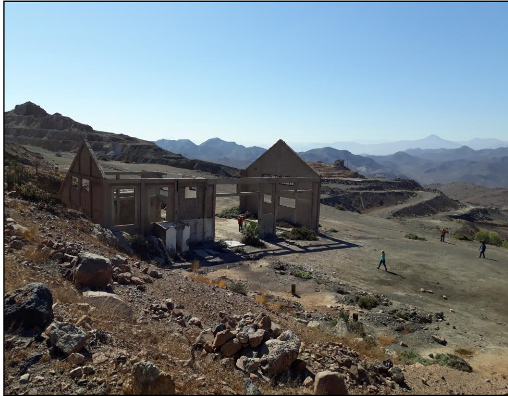
Figura 3.2 Fotografía en terreno de grupo de trabajo, visitando instalaciones e infraestructuras en sector mina Huantemé.
