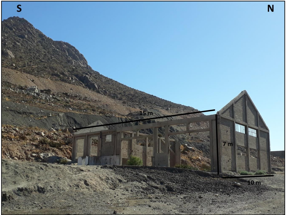
Figura 4.18 Fotografía tomada al taller mecánico. Observamos como la infraestructura de concreto exterior se mantiene, y sus dimensiones son de 15 m de largo, 10 m de ancho y 7 m de alto (sin contar el techo).
