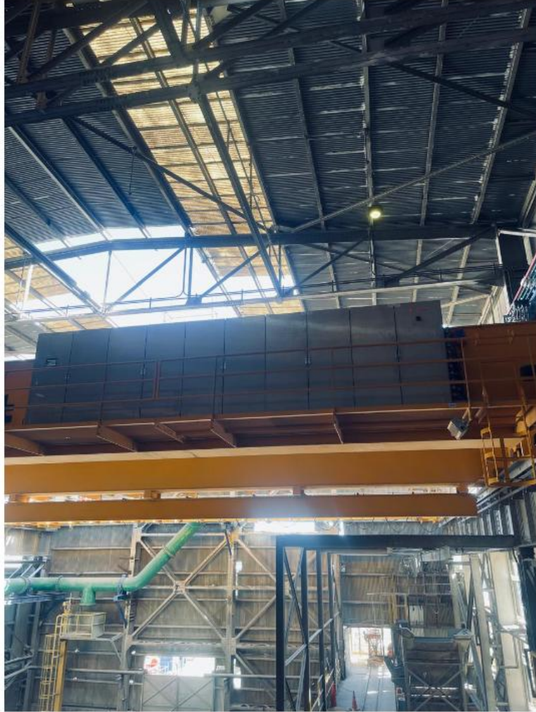
Figura N° 7.9: Vista frontal puente grúa post cambio de componentes.
