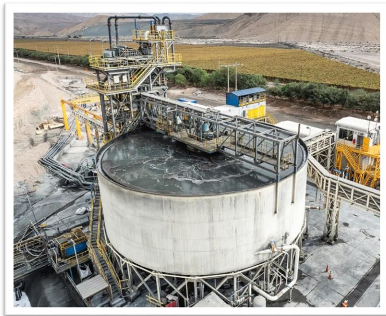
Figura N°2.2: Espesador de relave.
