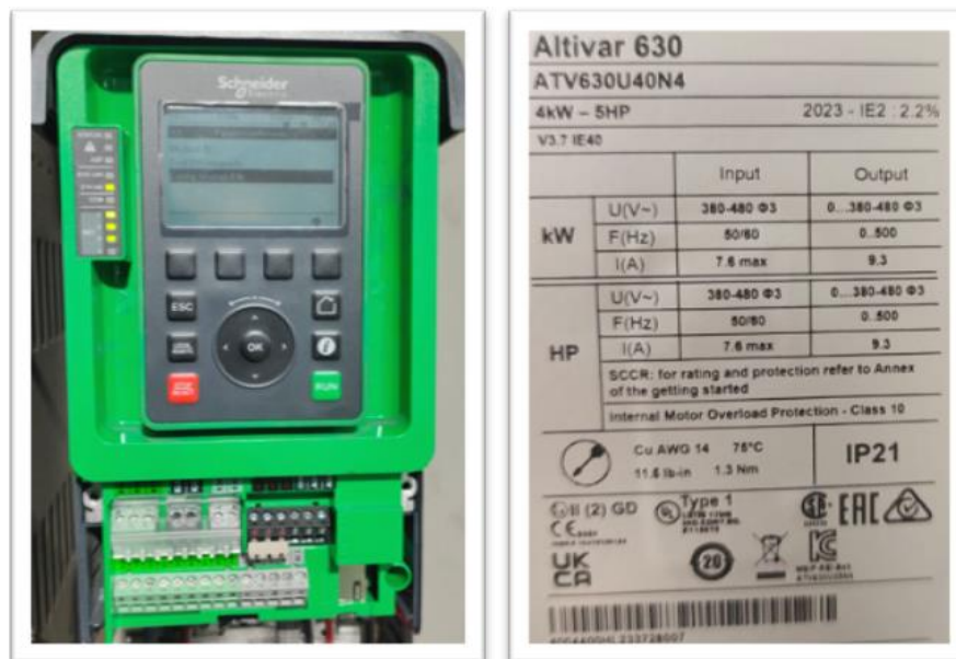
Figura N°3.4: VDF ALTIVAR 360 y características técnicas.
