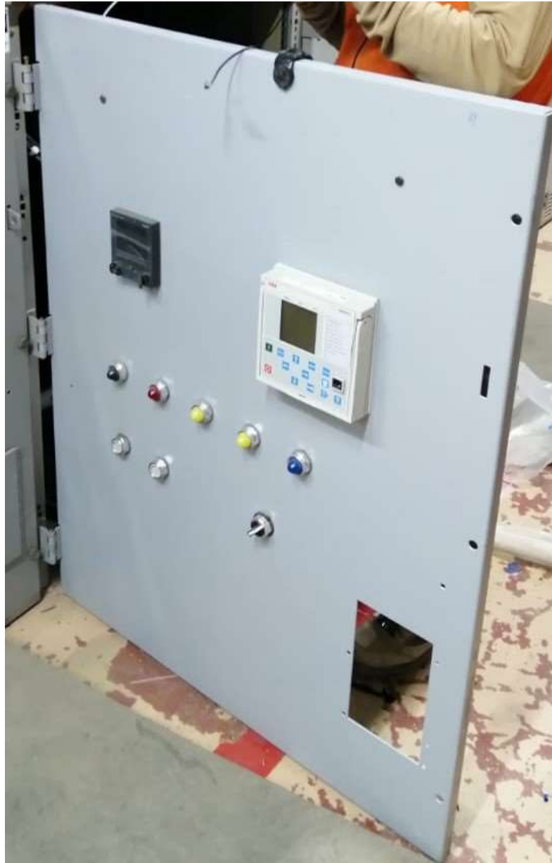
Figura N° 4.33: Instalación de nueva puerta.
