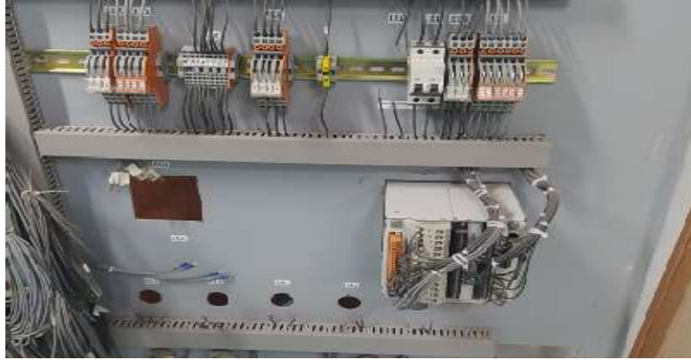
Figura N° 4.11: Cableado y etiquetado de nueva puerta.
