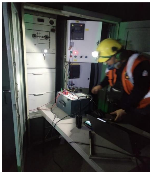
Figura N°4.9: Prueba de inyección de corriente
