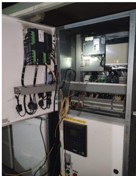
Figura N°4.10: Conexión SEPAM S20
