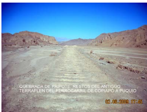
Figura 6.- En la Quebrada de Paipote se encuentran los restos del terraplén del ferrocarril Copiapó- Puquío que usó Curtis en la en su viaje al Llano de Varas.
